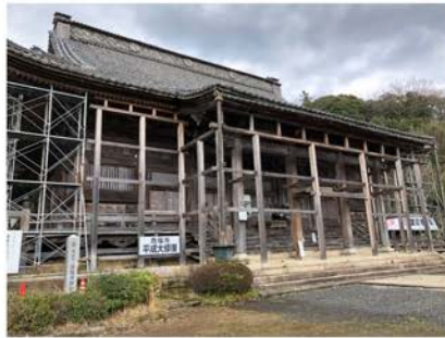
修復中の西福寺。御影堂、阿弥陀堂、書院等が国の重要文化財
